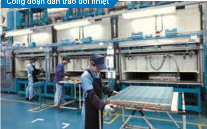
Công đoạn dàn trao đổi nhiệt
